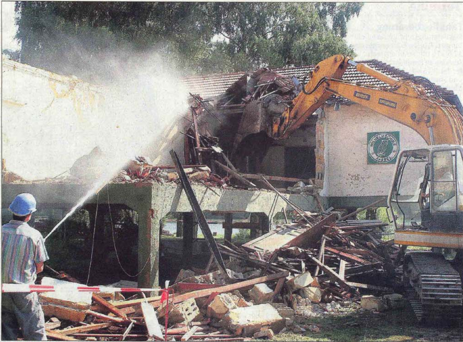
Der Bagger leistet Schwerstarbeit: Derzeit wird das alte Bootshaus abgerissen. Der Neubau soll in einem Jahr fertig sein.
